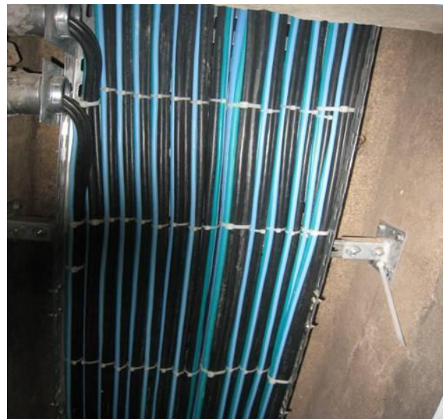
SITUAÇÃO ATUAL: PRUMADA NOVA COM CABOS DEVIDAMENTE AMARRADOS EM TRIFOLIO
