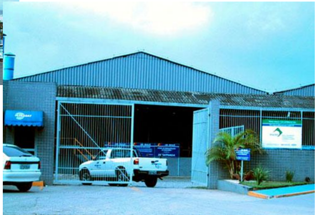
Área de Requalificação de Botijão com Processo de Automação
